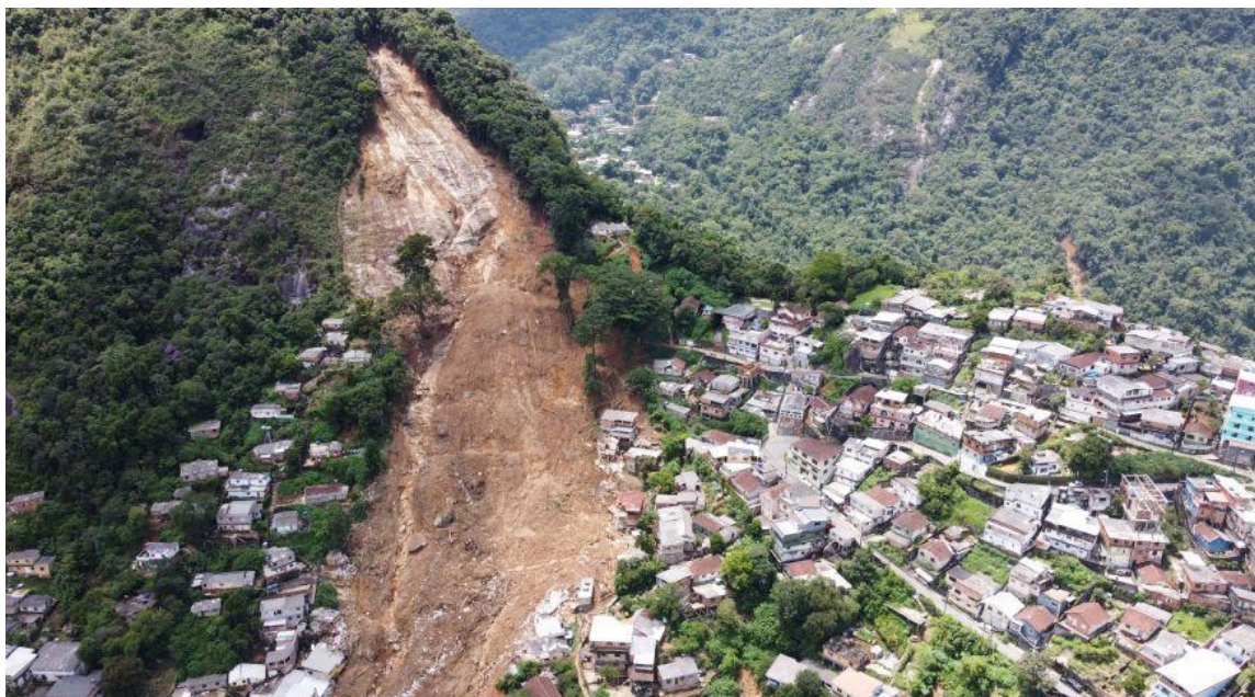
Figura 11: Deslizamento de terra no Morro da Oficina - Petrópolis, 2022 (Fonte: REUTERS/Ricardo Moraes).
