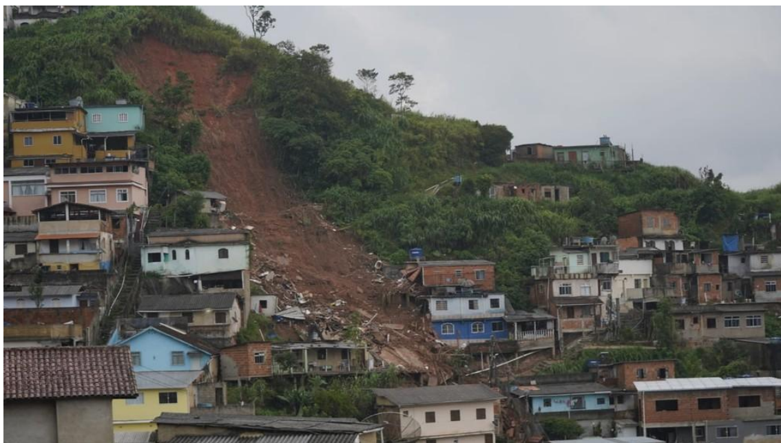
Figura 10: Deslizamento próximo à Rua 24 de Maio, em Petrópolis – fevereiro/2022
