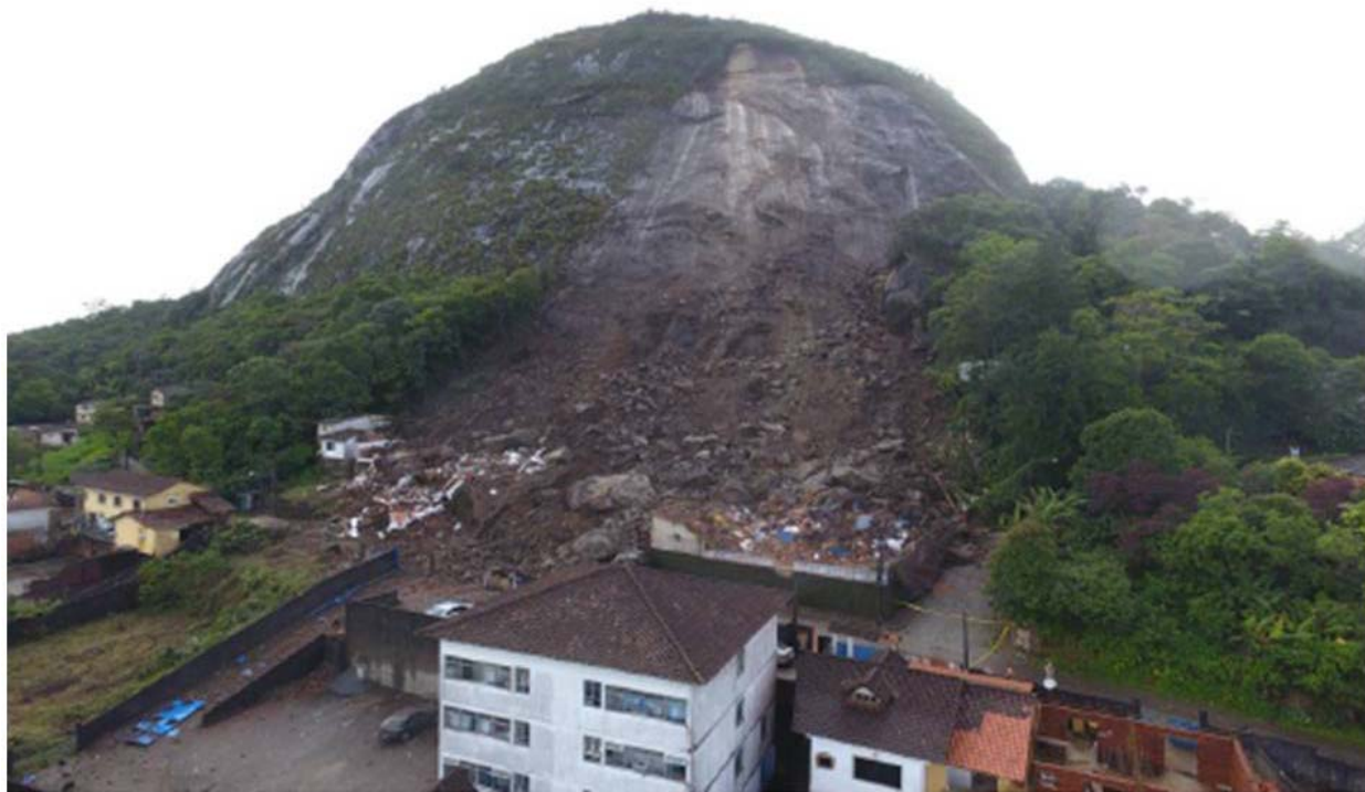
Figura 2 - Desastre ocorrido no dia 14 de novembro de 2016, na Rua Uruguai – Bairro Quitandinha.
